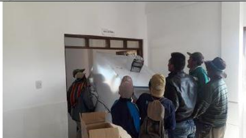
Organización de equipos y materiales para iniciar el trabajo
